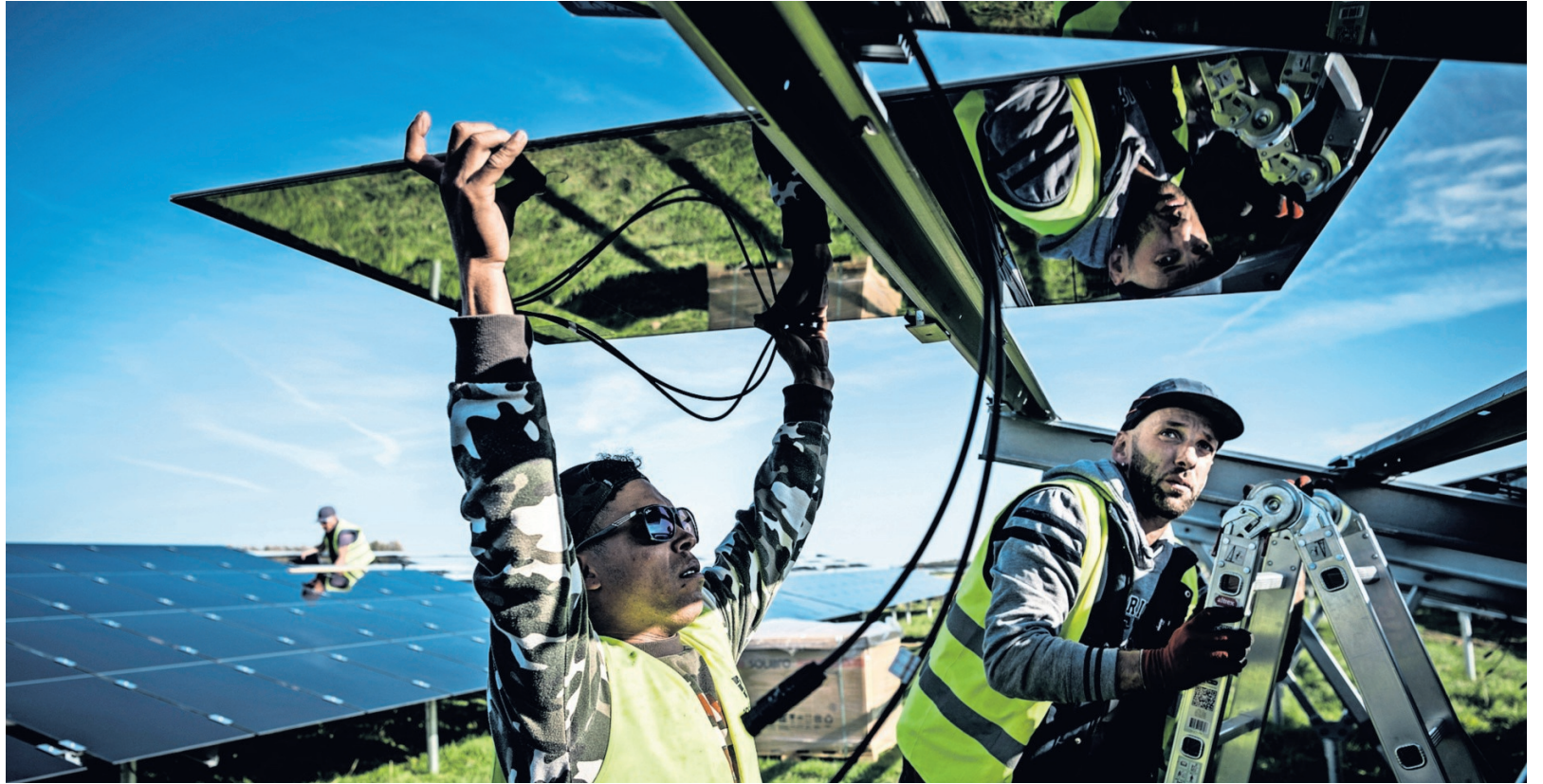
Aanleg van het zonnepark bij industriegebied Roodehaan in Groningen door werknemers van het Portugese bedrijf Enersado. FOTO KEES VAN DE VEEN
